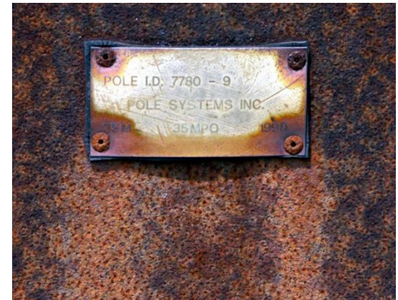
Corrosão galvânica dos parafusos de aço ao carbono pelo contato com chapa de latão
