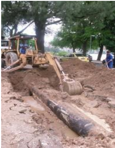
Reparo em adutora de água
