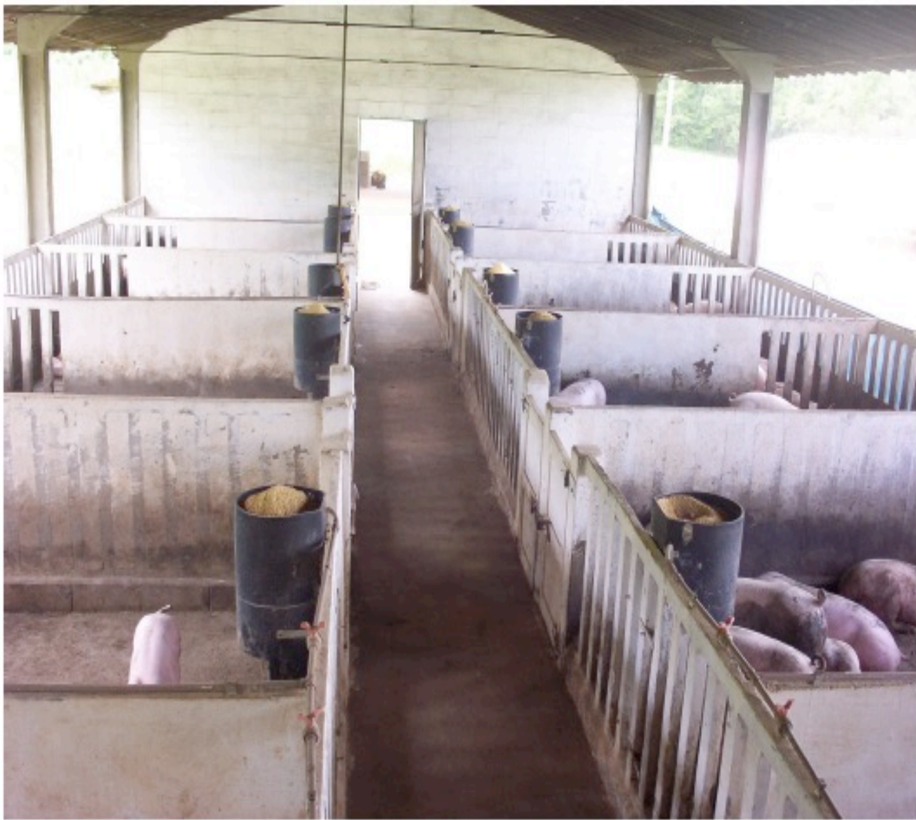
Fig. 3 - Divisórias de concreto pré-fabricadas, facilitando a ventilação natural.
