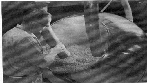
Figura 5-50. Revestimento de comprimidos. Antiga dragadeira para revestimento, mostrando a aplicação de ar quente e a sua exaustão. (Cortesia de Wyeth Laboratories.)
