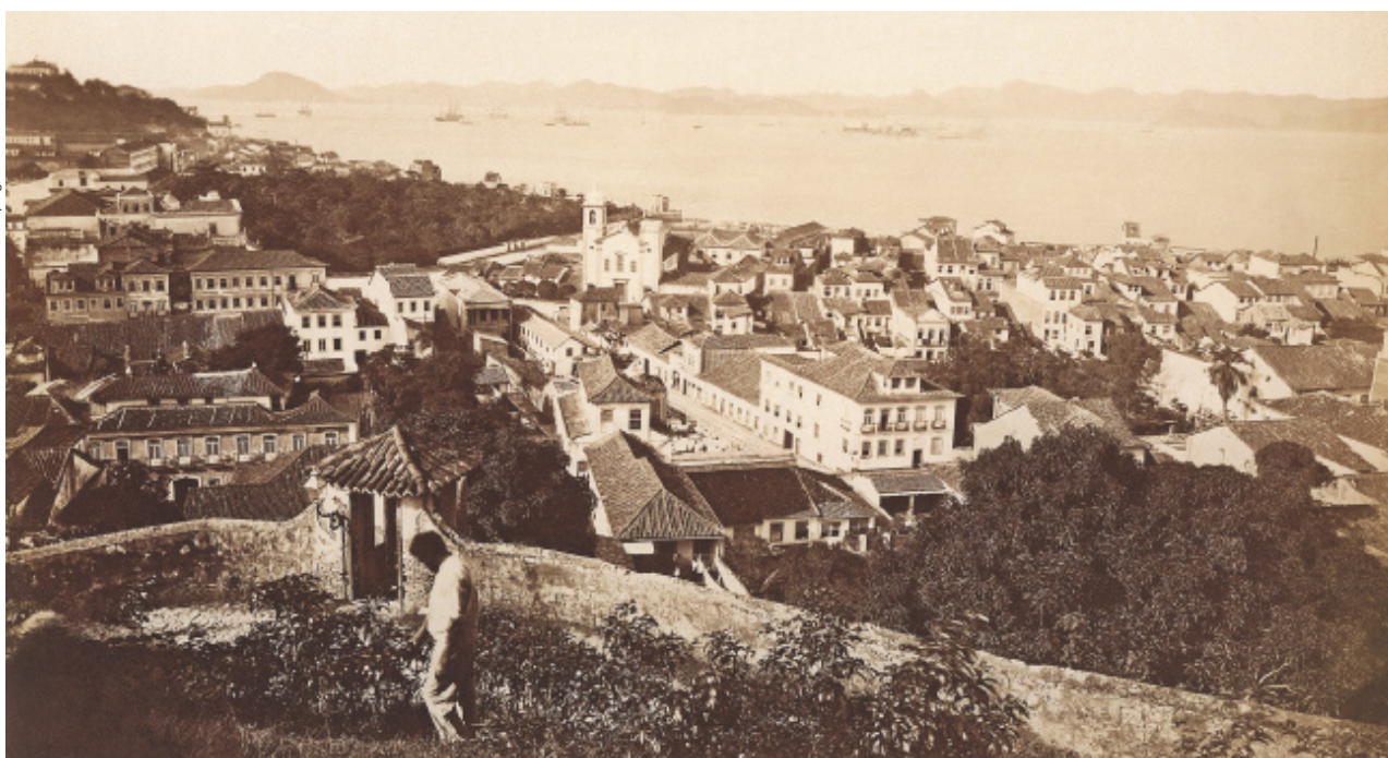
A foto retrata o Morro de Santa Teresa, na cidade do Rio de Janeiro (RJ), em cerca de 1867, com seus casarões inspirados na arquitetura francesa da época. O bairro ficava a meio caminho entre a Floresta da Tijuca e a cidade de Petrópolis, para onde iam ricos e nobres no verão.
