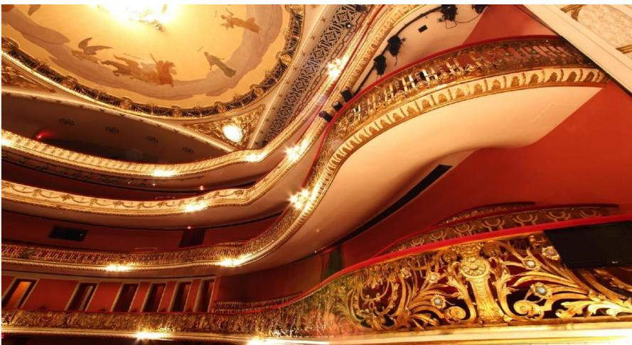
Figura 394: Detalhe dos balcões em balanço. Foto: Francisco Pereira de Figueiredo.
