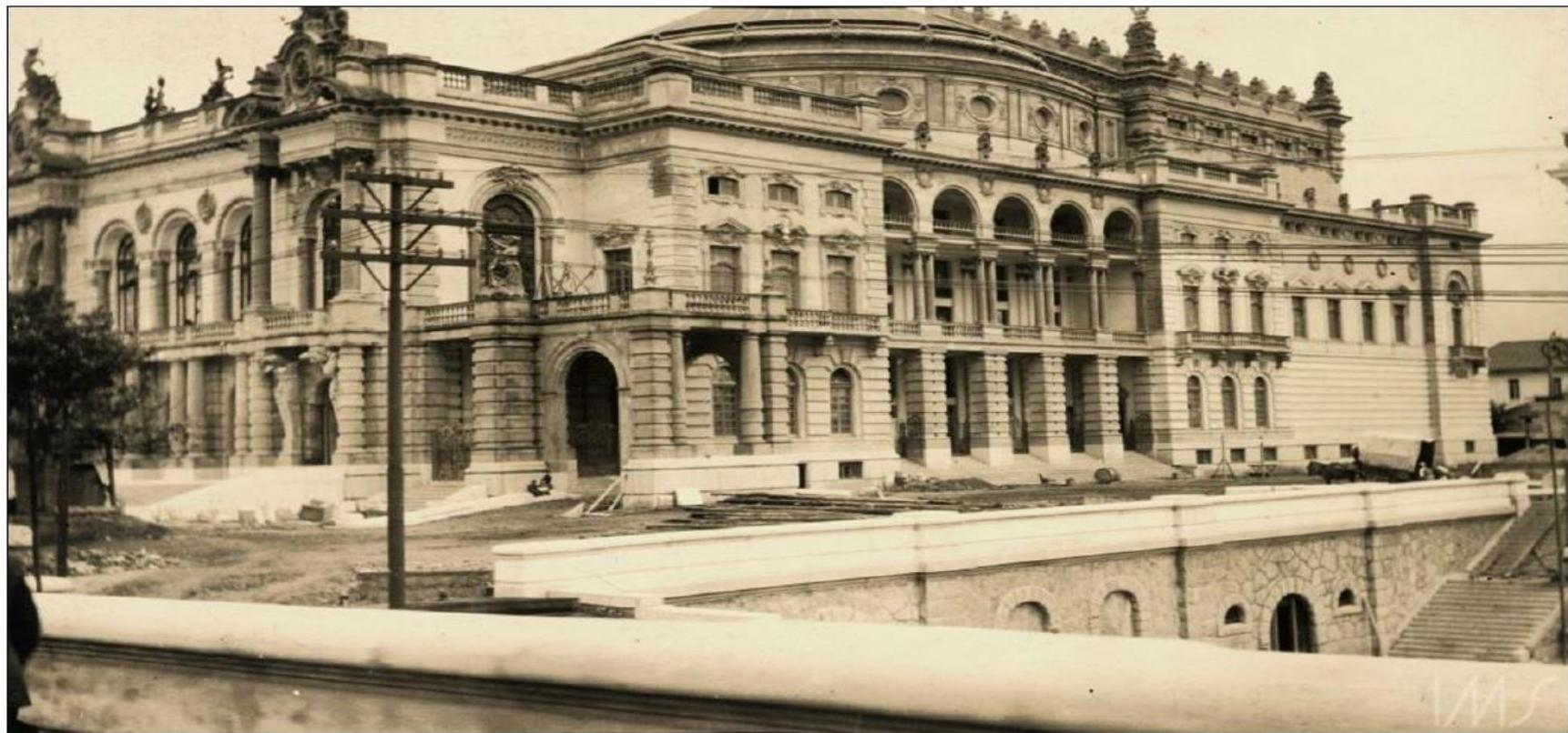
Figura 15: O Teatro Municipal em 1910: pode-se vislumbrar que as obras da esplanada estavam adiantadas, com o muro de contenção e a escadaria de acesso já prontos. Notar o entorno do teatro, ainda sem pavimentação. Fonte: IMS.
