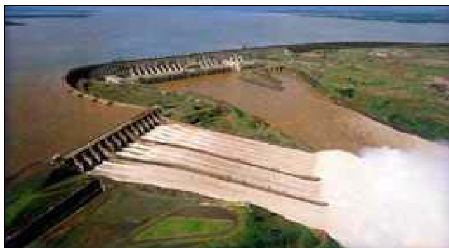
Figura C.03- Vista aérea da usina (ITAIPU BINACIONAL, 2002).
