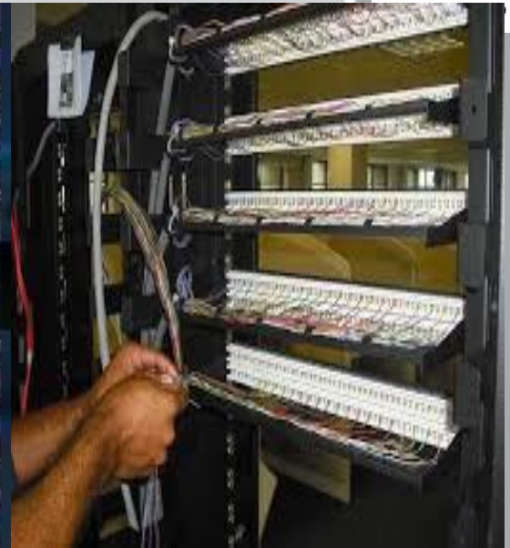
Distribuidor de Cabeação
