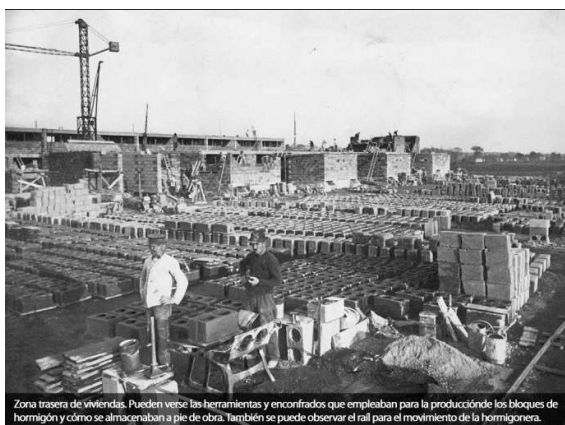
Imagem 4: Construção das Siedlungs na Alemanha com os componentes industrializados no canteiro de obras.
