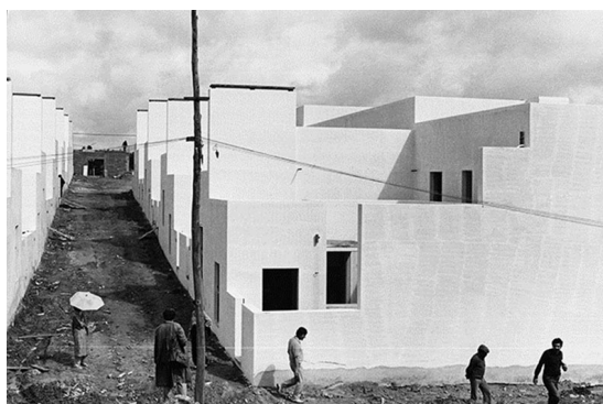
Imagem 7: Construção das unidades habitacionais da Malagueira em Évora no final dos anos de 1970. Fonte: http://socks-studio.com/2016/05/13/quinta-da-malagueira-in-evora-by-alvaro-siza-1977-1998/
