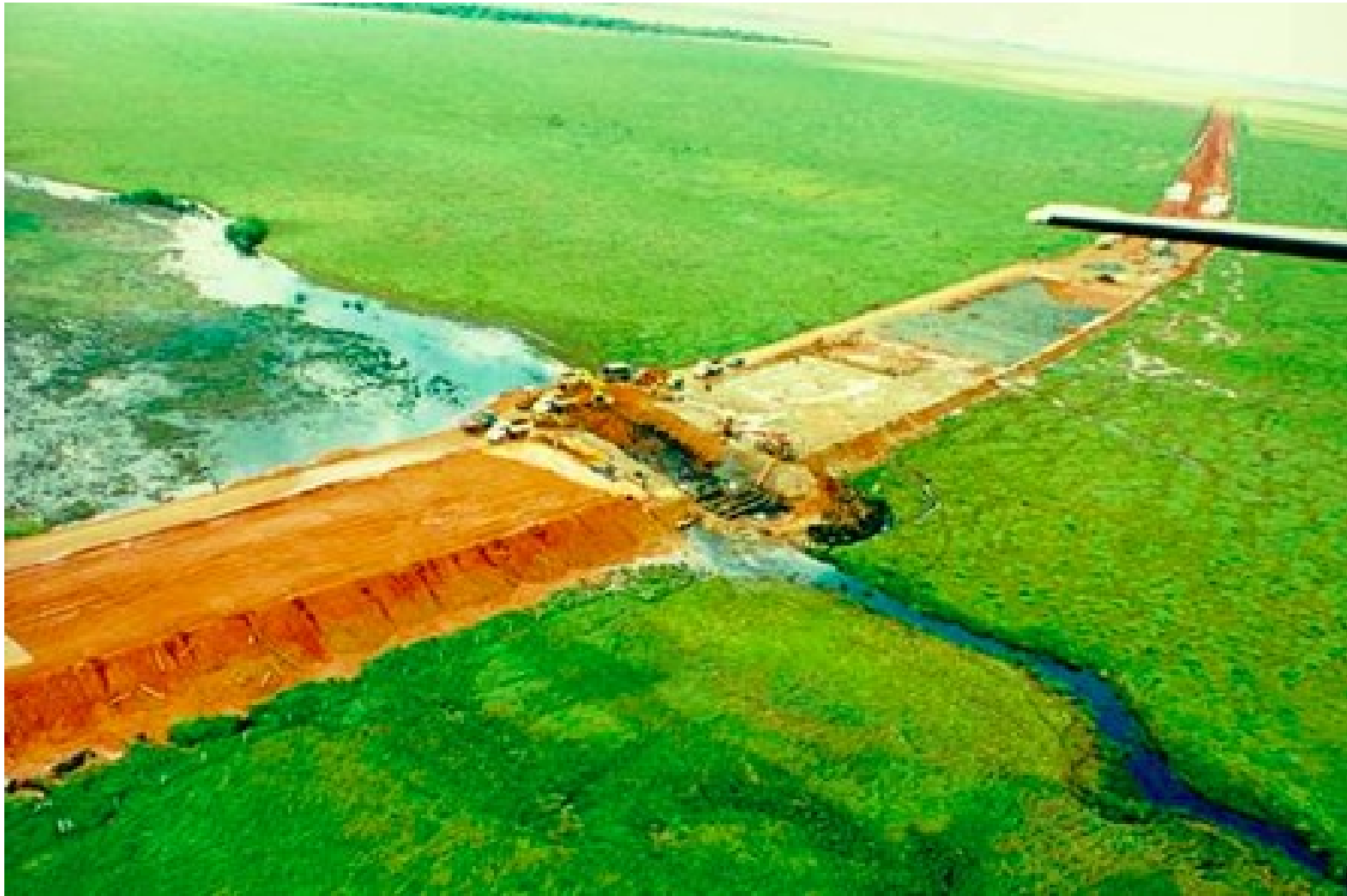
Primeira obra no Brasil – Chapadão do Sul/MS - 1999
