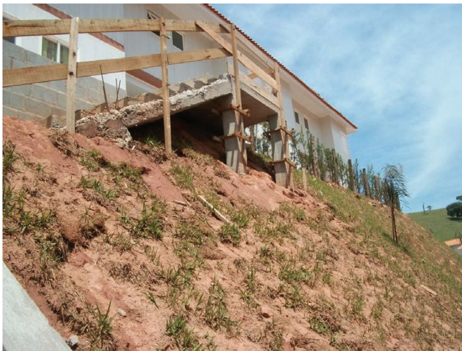
Figura 54: Escada de acesso aos sobrados do Conjunto Habitacional Casinha Branca, São Luiz do Paraitinga, onde fica visível a ausência de contenção do solo na implantação das casas. Fonte: Unesp, 2011.
