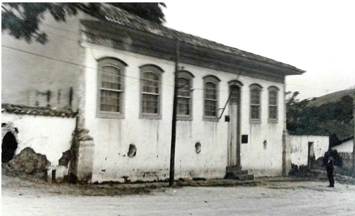
Figura 27: Casa natal de Oswaldo Cruz, São Luiz do Paraitinga. Já se notam alterações na edificação, desde seu tombamento pelo Iphan em 1956. Fonte: Arquivo Condephaat, 1969.
