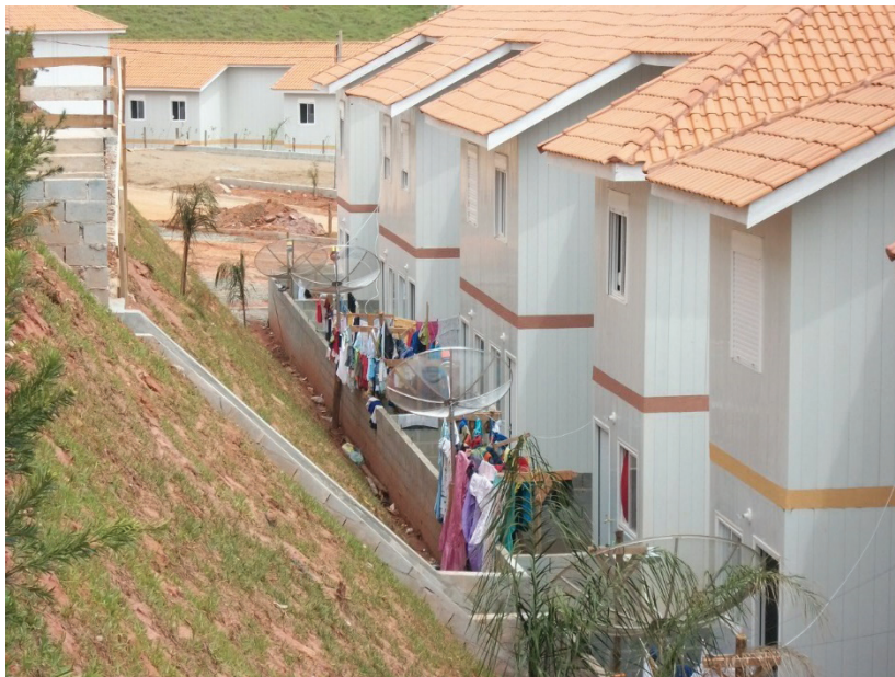
Figura 53: Vista dos fundos dos sobrados do Conjunto Habitacional Casinha Branca, São Luiz do Paraitinga. Fonte: Unesp, 2011.
