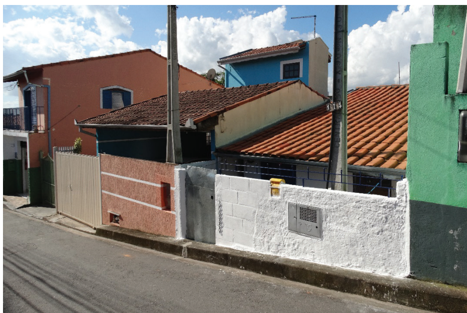
Figura 69: Casas abaixo do nível da rua, localizadas na subida para o mirante da torre (Rua Dr. Luiz de Aguiar), bairro do Alto do Cruzeiro, São Luiz do Paraitinga. Fonte: Acervo da pesquisa, 2020.
