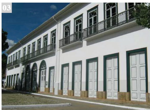
Figura 3: 01. Palácio 10 de Julho do Barão de Itapeva, Pindamonhangaba/SP; 02. Solar Aguiar Valim, Bananal/SP; 03. Palacete do Conde Moreira Lima, Lorena/SP.
