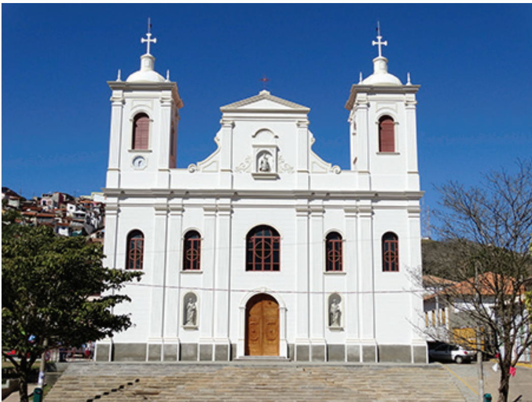
Figura 41: Igreja Matriz de São Luís de Tolosa, depois da enchente, São Luiz do Paraitinga.
