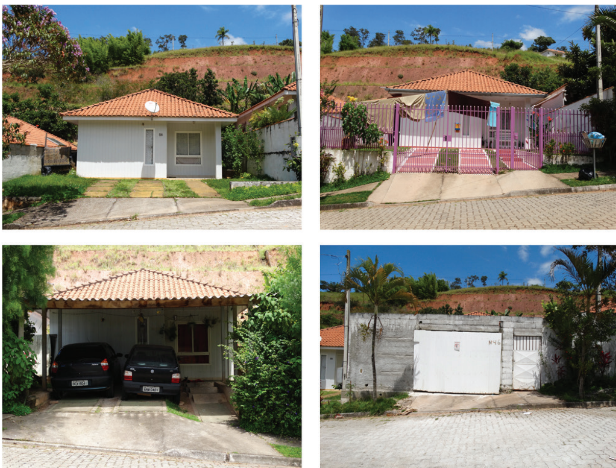
Figura 55: Casas térreas do Conjunto Habitacional Casinha Branca, São Luiz do Paraitinga, modificadas por seus moradores, com a construção de muros frontais e laterais, telhado para abrigo de carros, pinturas diferenciadas e revestimentos no piso. Fonte: Acervo da pesquisa, 2020.
