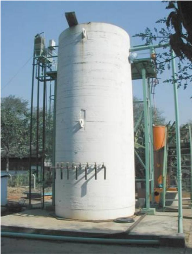
Biodigestor modelo RAFA: Reator Anaeróbio de Fluxo Ascendente
