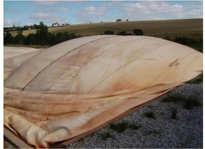
Biodigestores mais utilizados na área rural - biodigestor modelo canadense, também conhecido como biodigestor rural ou lagoa coberta.
