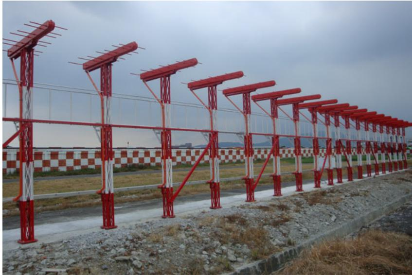
Figura 12 – Exemplo de Antena do LOC
