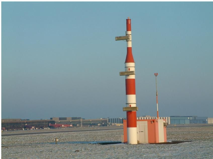
Figura 13 – Exemplo de Antena do GS
