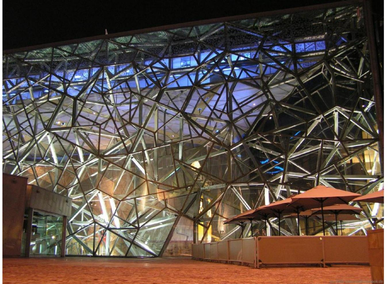
A autossimilaridade fractal dos painéis se torna uma qualidade vital para se obter coerência e diferença nas fachadas.
