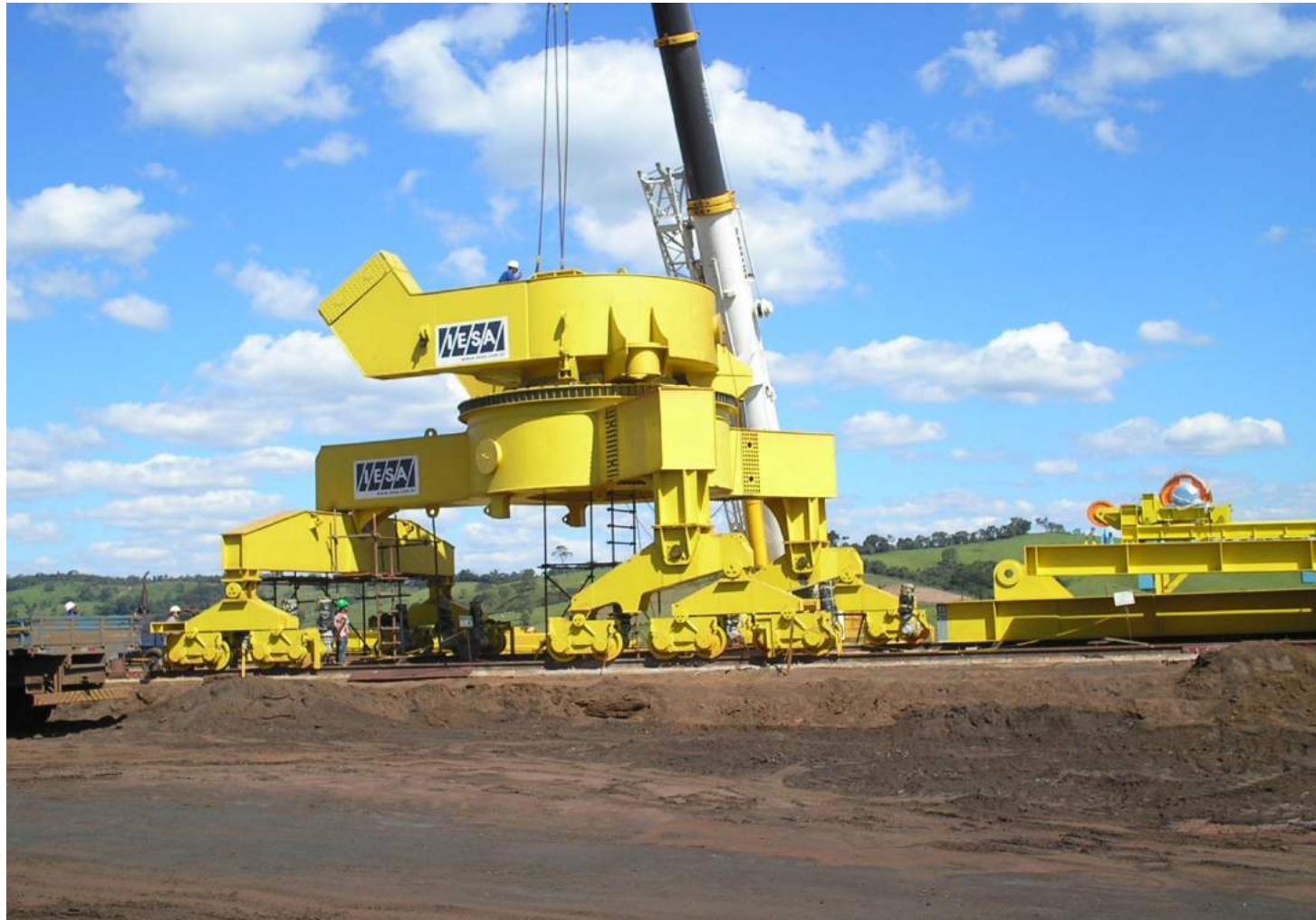
Estrutura Giratória sendo montada sobre Estrutura do Portal e o Conjunto da Translação, compondo a base de sustentação da Empilhadeira
