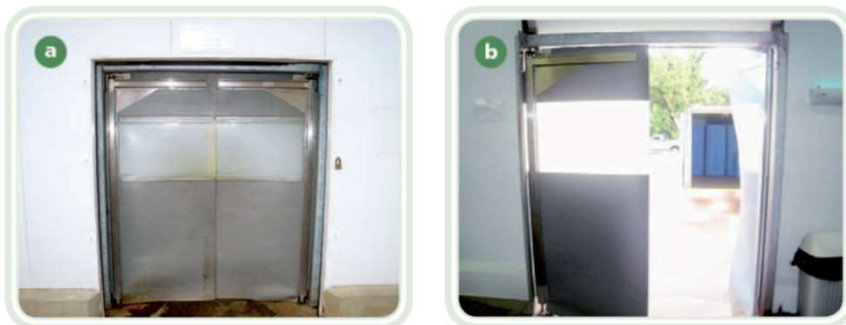
Figura 1: Portas com sobre portas do tipo vai e vem
