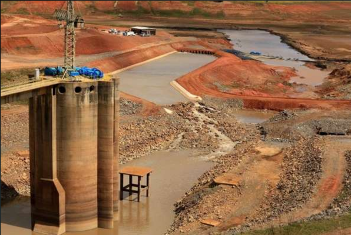
Bombeamento do volume morto do reservatório Jaguari – Jacareí Sistema Cantareira
