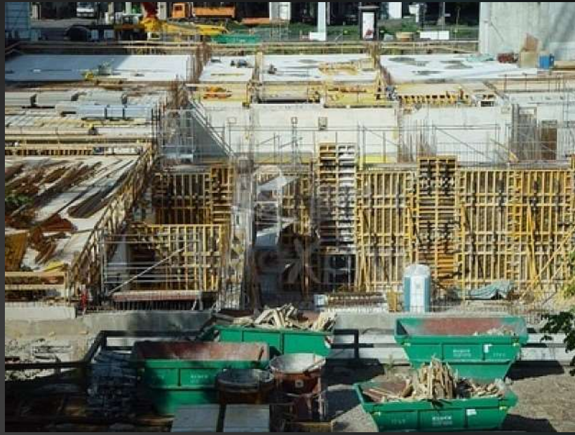
Canteiro de Obra
