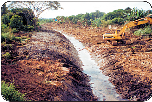
Foto 29 – Retificação de Canal Natural
