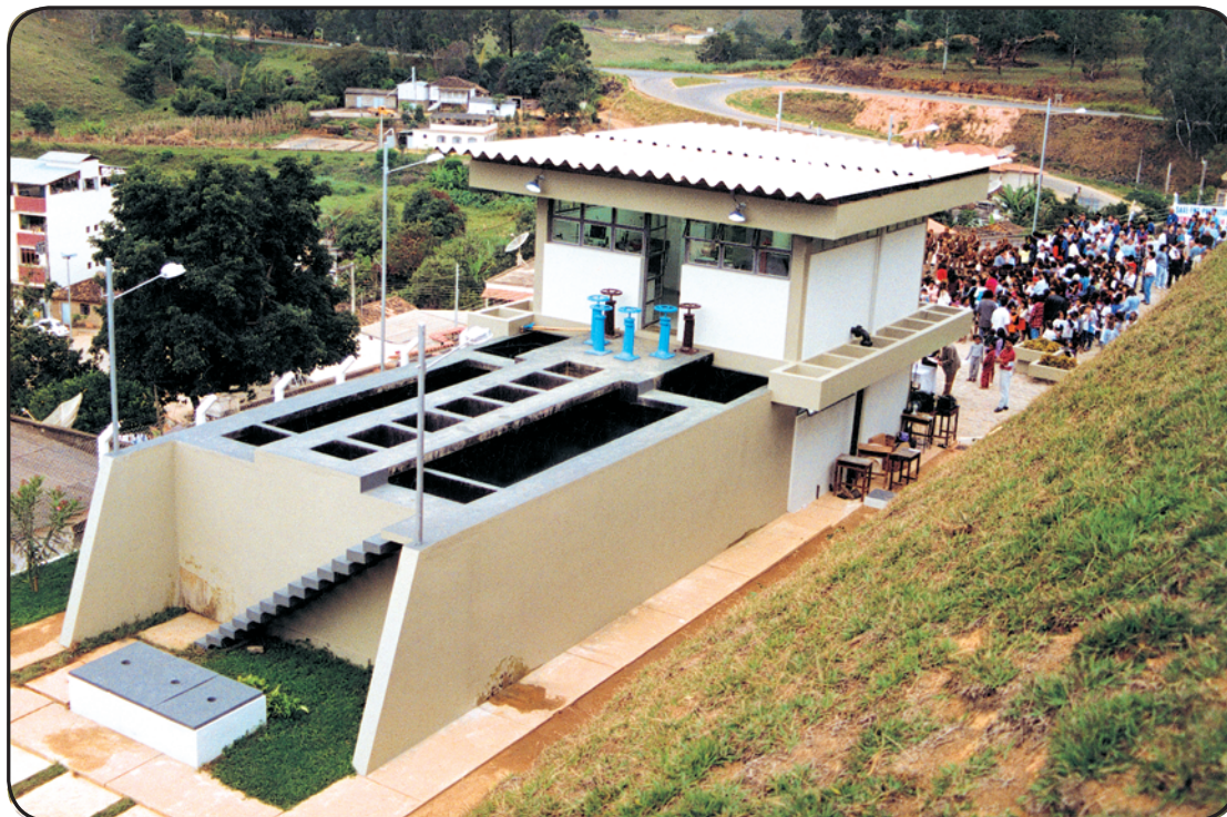
Foto 2 – Estação de tratamento de água convencional – capacidade 5l/s São Pedro do Avai - Manhuaçu/MG
