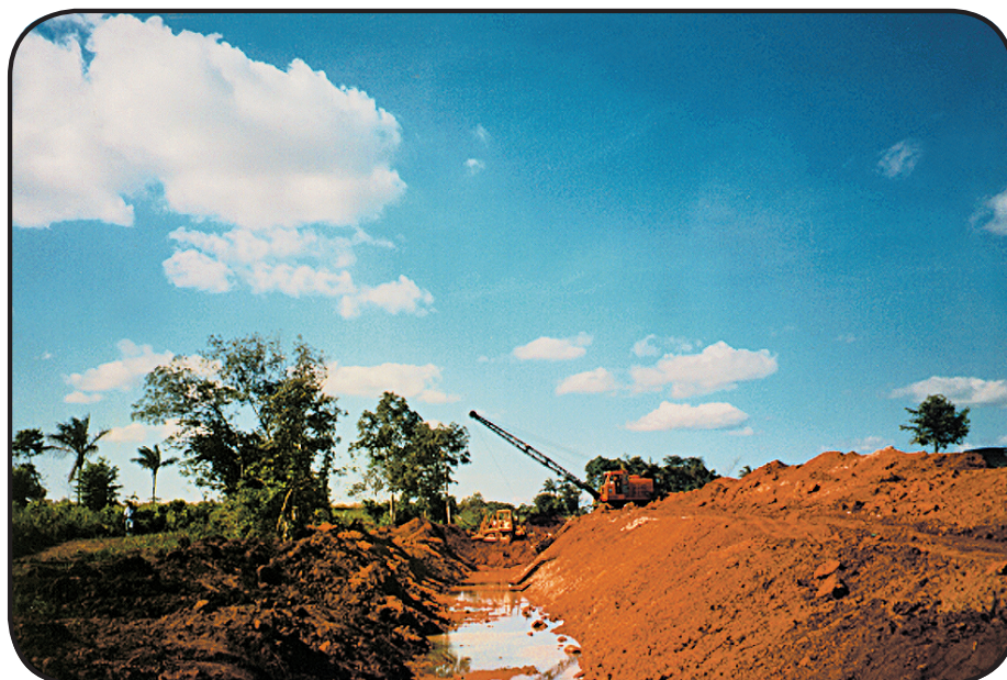
Foto 31 – Dragagem com drag-line
