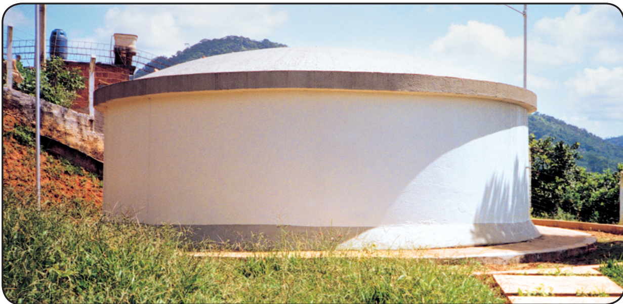
Foto 5 – Reservatório em concreto armado apoiado
