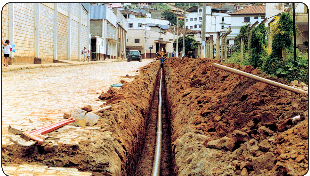
Foto 6 – Rede de distribuição em PVC PBA
