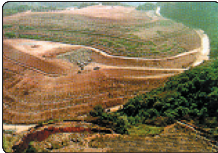
Foto 28 — vista aérea de um aterro sanitário
