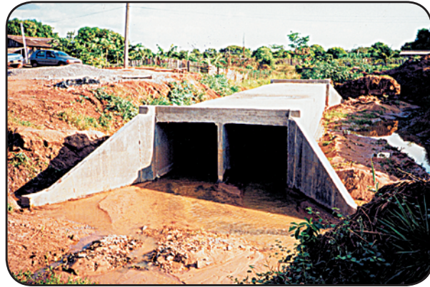
Foto 30 – Galeria de Concreto Armado
