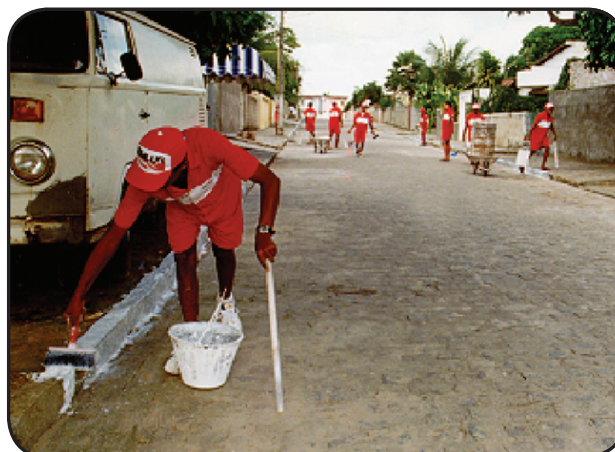
Foto 18 – Pintura de meio-fio
