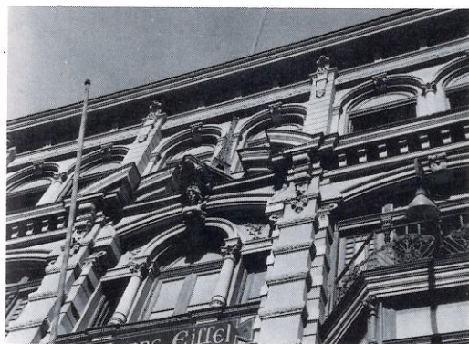
667 C. Arno Gierth — Casa Torre Eiffel (demolida), rua do Ouvidor, Rio de Janeiro.
