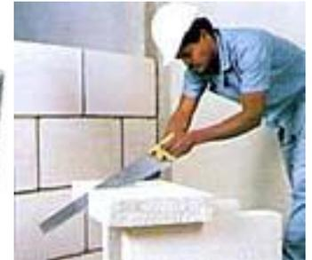
**Concreto celular autoclavado:** para vedação ou estrutural
