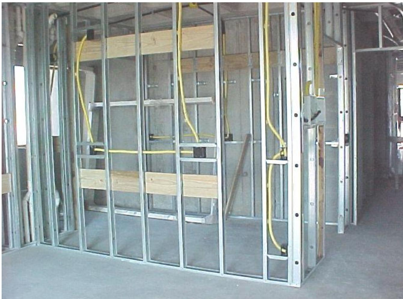
Montantes metálicos da estrutura da parede
