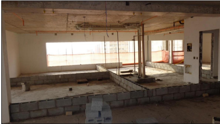
Figura 11 - Muretas para Dividir as Piscinas na Laje (Acervo da pesquisa, 2014).
