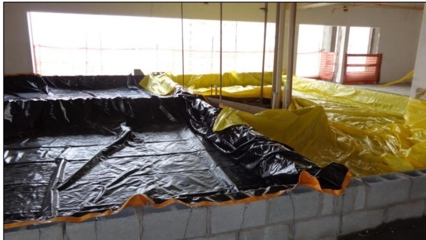
Figura 11 - Muretas para Dividir as Piscinas na Laje (Acervo da pesquisa, 2014).
