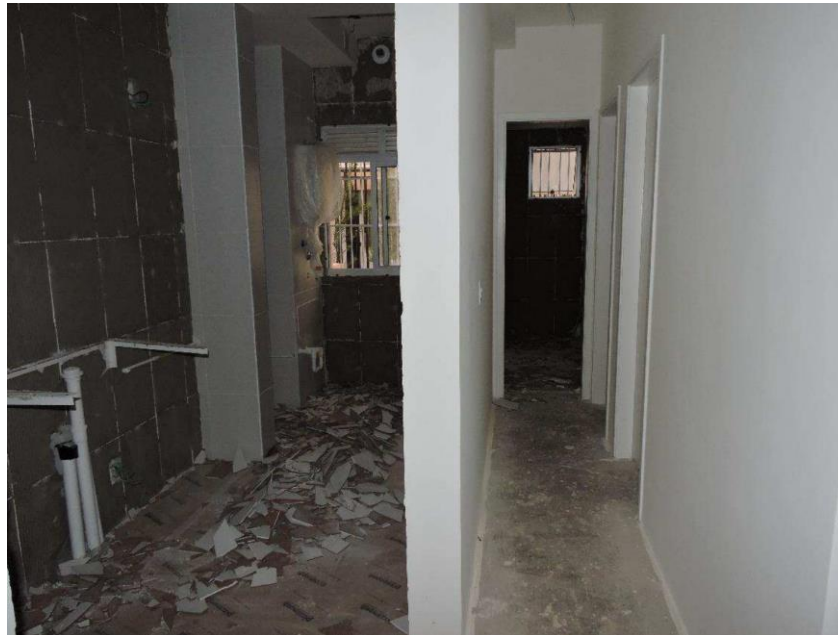
Asas de material removido em decorrência de ruptura entre o revestimento e a argamassa diante por solicitações posteriores ao assentamento: fato recorrente observado de forma generalizada
