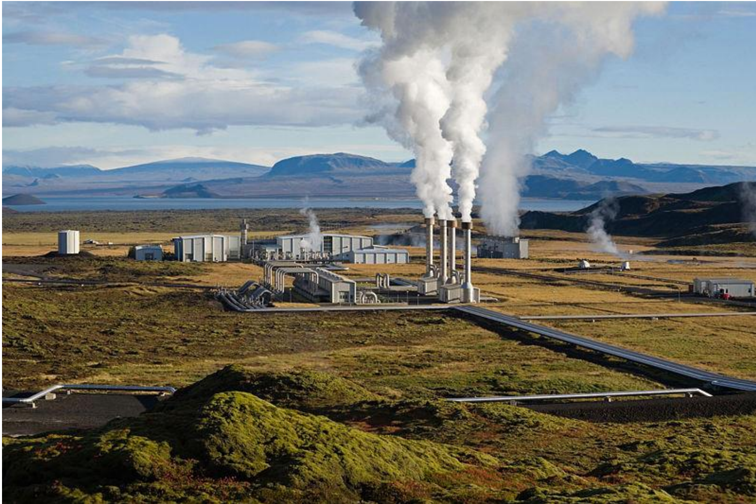
Planta para geração de energia elétrica (Nesjavellir, Islândia)
