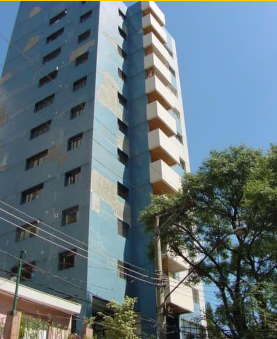
Fachadas Oeste e Norte
