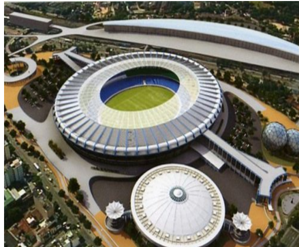
Estádio Maracanã – Rio/RJ LEED NC v.3 – Fev/11
