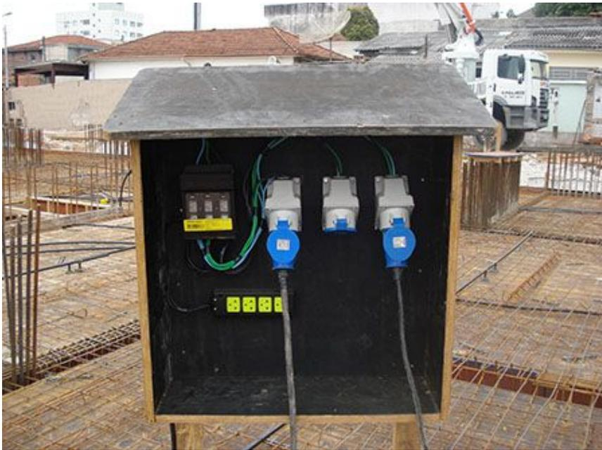
Quadro de pontos de tomada provisório montado em canteiro.
