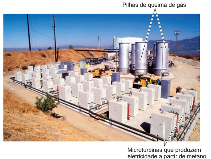
**Figura 28.15 Produção de metano a partir de resíduos sólidos em aterros.** O metano acumula-se nos aterros e pode ser usado para energia. Esta instalação perto de Los Angeles tem 50 microturbinas que geram eletricidade a partir do metano produzido em um aterro. Logo atrás das microturbinas estão cinco pilhas de queima de gás que encobrem o excesso de metano queimado – uma exigência para que as aeronaves não confundam isso com a iluminação do aeroporto.
