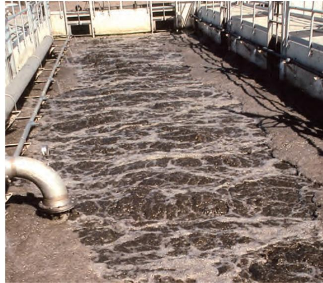
(b) Um tanque de aerção, mostrando a superfície espumando devido à aeração.
