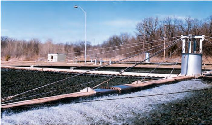
(a) Braço do pulverizador rotativo de um sistema de filtro biológico.
