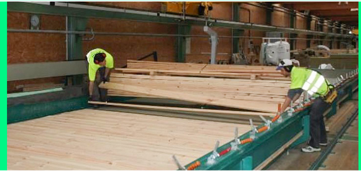
IMG. 6 Colocação das tábuas em prensa CLT. Imagem retirada de vídeo institucional Egoín: egoin.com/category/videos .
