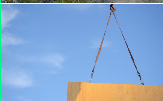
IMG. 14 Içamento da primeira peça de CLT da capela. Imagem por MAPA.
