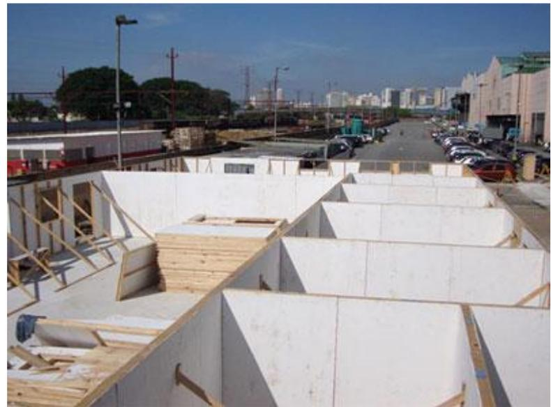
Escoras nas paredes na montagem do sistema BNC
