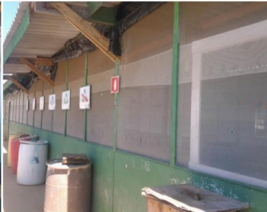
Refeitório com parede à meia altura e fechamento com telas de nylon, protegendo da poeira e melhorando condições de iluminação e ventilação.
