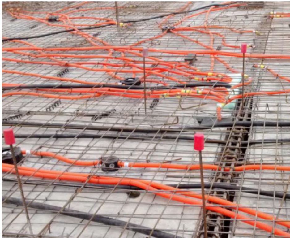
Produção Sistema “polvo” (Fonte: Sanhidrel Engekit, 2015).
