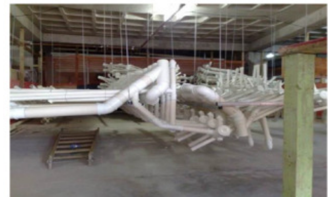
Separação de kits esgoto. (Fonte: Sanhidrel);
