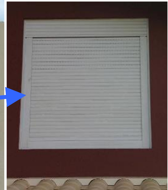
Esquadria após a retirada da proteção
