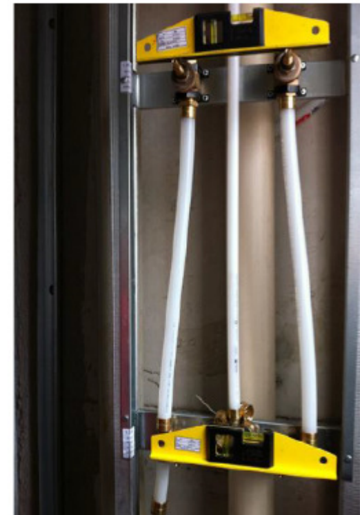
Verificação de nível. (Fonte: SANHIDREL, 2015).
