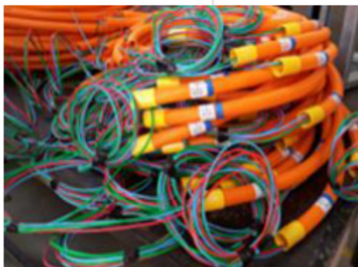
Distribuição p/ teto Sistema "polvo" – Sanhidrel
