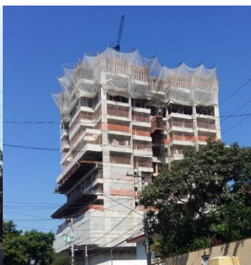
Predio em construção na rua Draúcio
