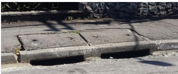
Boca de lobo (rua Dráusio)
