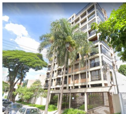
Prédio com segurança na rua Catequese
