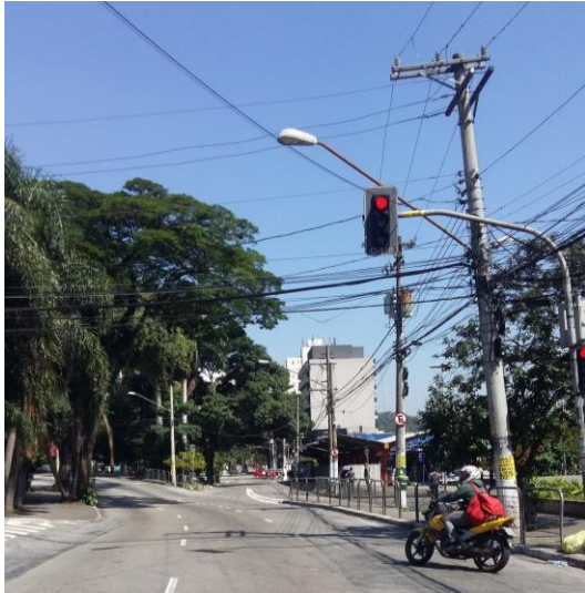
Cabos aéreos (rua MMDC)
