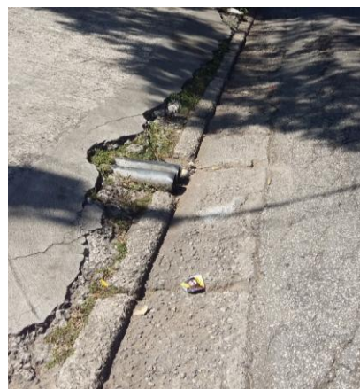
Tubulação de chegada de água (rua Alvarenga)
