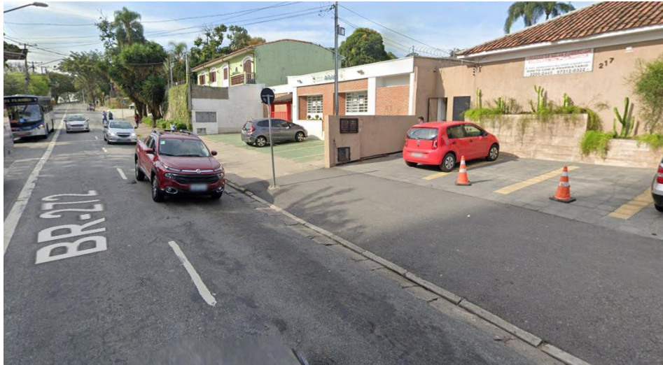
rua MMDC - calçada em boas condições
