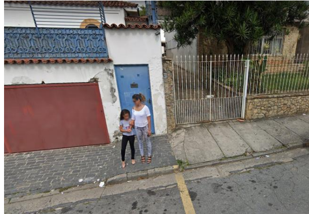
Calçada em mal estado (rua Dráusio)
