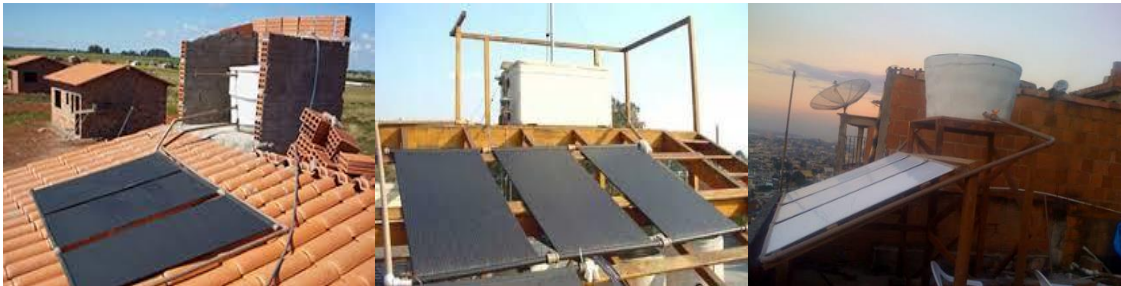
Figura 10. Exemplos de instalações de aquecedores solares em residências.
