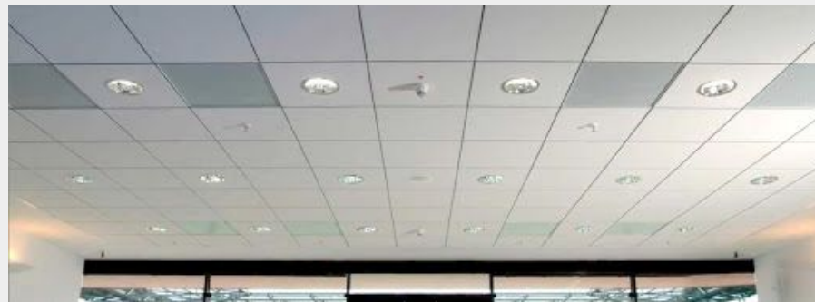
Sistema convencional tegular de forro
