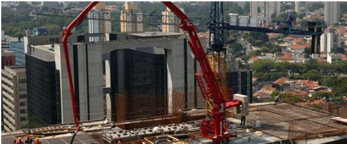
**Figura 2.** Mastro de distribuição do tipo Placing Boom.
