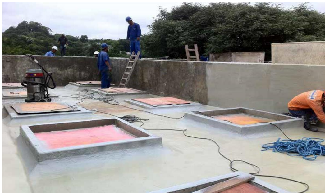
Figura 10: Aplicação do novo sistema de impermeabilização à base de poliureia na última campanha de obras no Edifício Vilanova Artigas. Foto: Claudia Oliveira, 2013.
