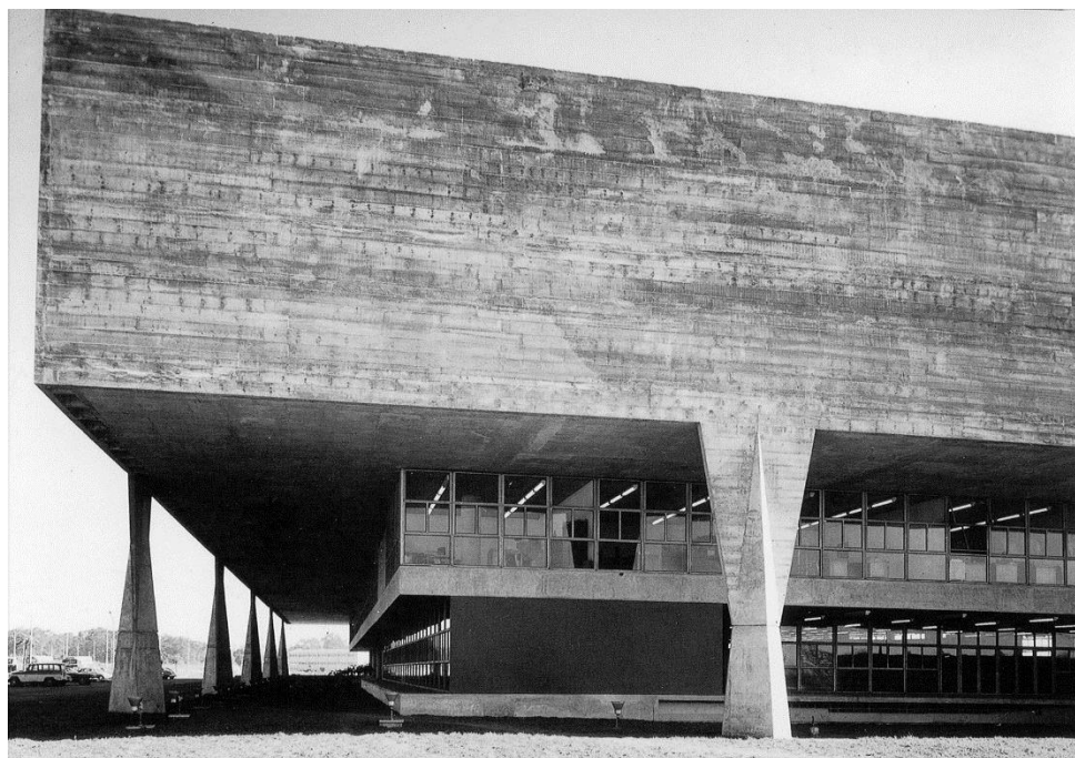
Figura 3: Vista das empenas de concreto apoiadas nos pilares externos. Fachada Sudeste. Autor e data desconhecidos. Fonte: Acervo da Biblioteca da FAUUSP.
