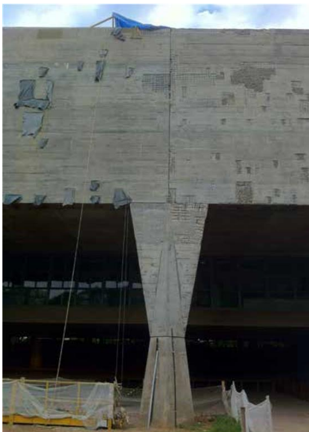
Figura 9: Reparos no concreto das fachadas na última campanha de obras no Edifício Vilanova Artigas. Foto: Claudia Oliveira, 2013.
