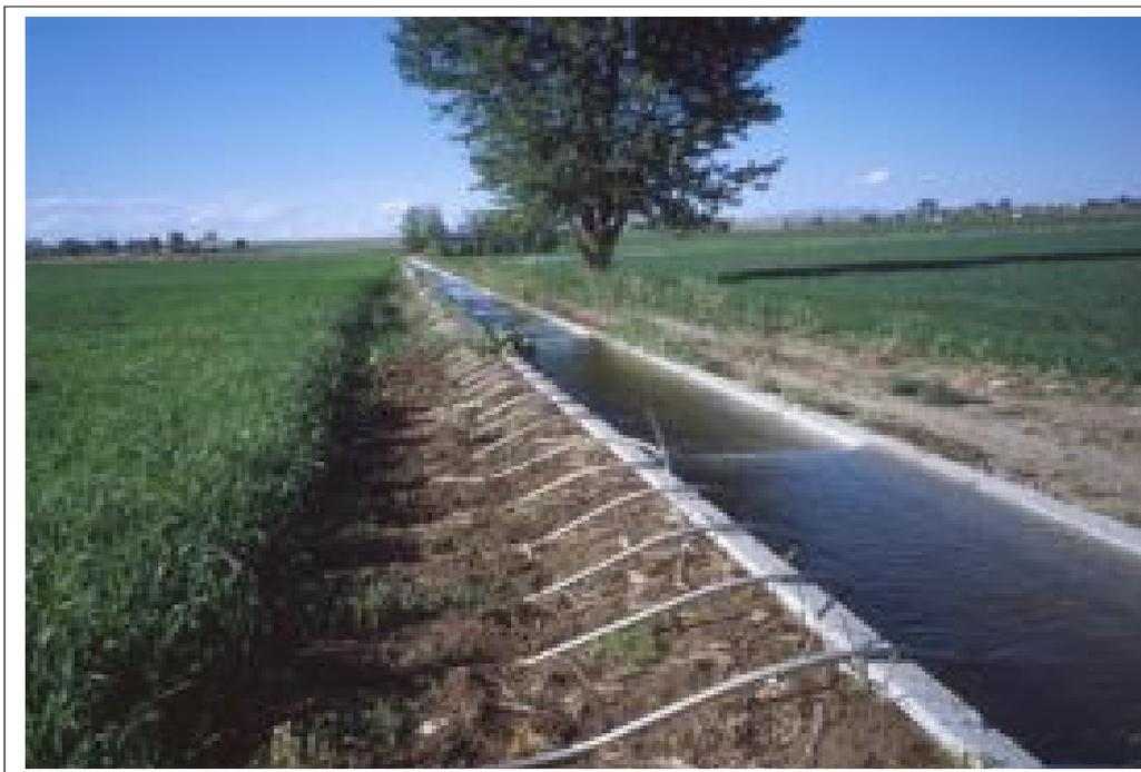
Figura IX.1c – Sistema de irrigação por sulcos de infiltração, apresentando detalhe do canal com comportas para controle de carga hidráulica.
