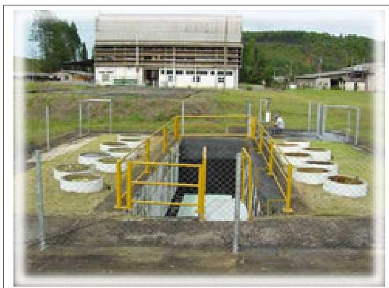
Figura II.1 – Bateria de lisímetros de drenagem em operação.
