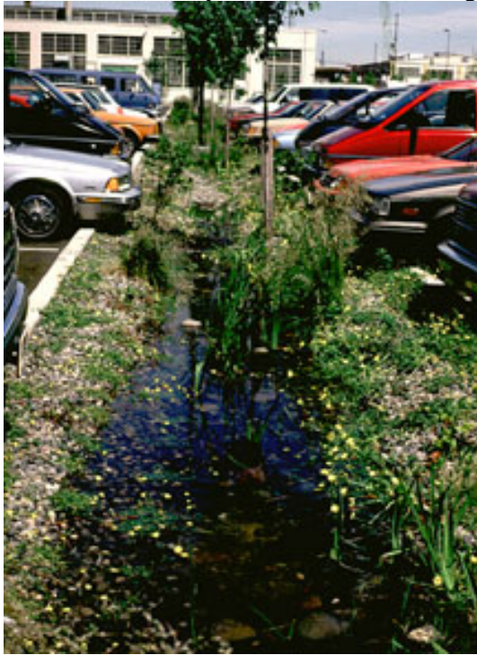
Fig. 12- A biovaleta do estacionamento do Museu de Ciências e Indústria de Oregon (OMSI), Portland, Oregon. Fonte: Murase Associates
