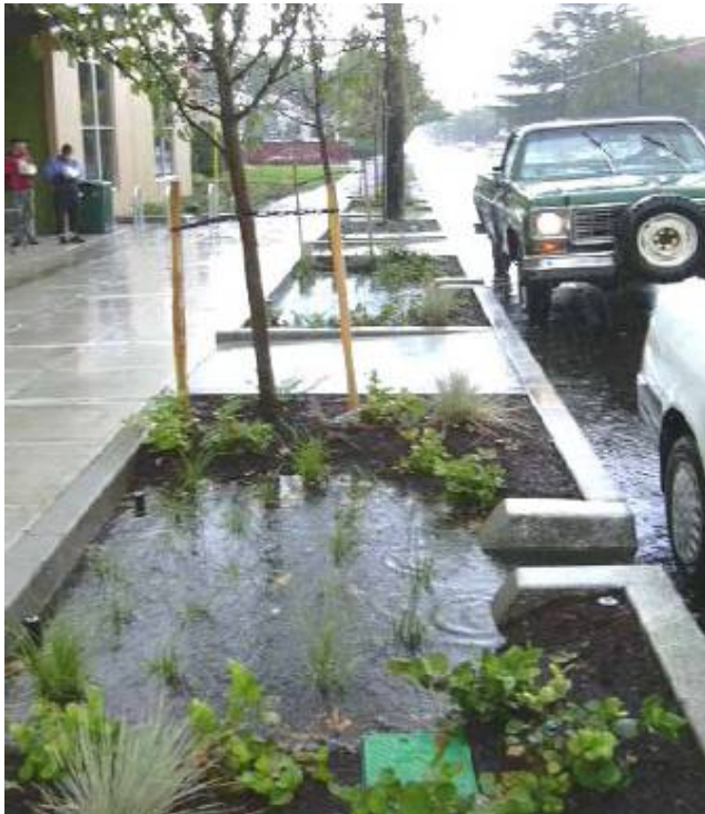
Fig. 7- Os canteiros pluviais junto ao New Seasons Market em Portland, Oregon. Fonte: City of Portland Bureau of Environmental Services
