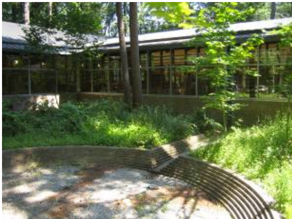
Fig. 3- Jardim de chuva da Biblioteca Maple Valley, Maple Valley, Washington. Fonte: Nathaniel S. Cormier
