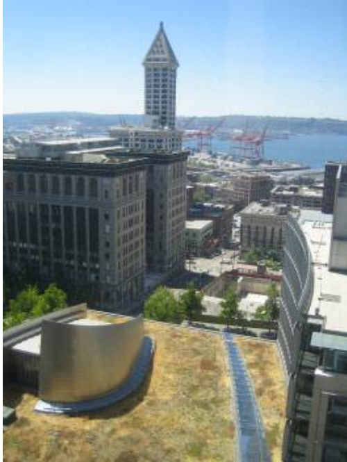
Fig. 18- Uma vista da cobertura da nova prefeitura de Seattle, Washington. Fonte: Nathaniel S. Cormier
