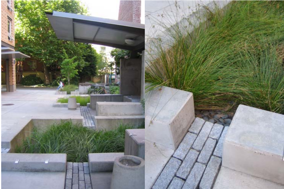
Fig. 26-Canteiro pluvial moderno do Stephen Epler Dormitory em Portland, Oregon. Fonte: Nathaniel S. Cormier
