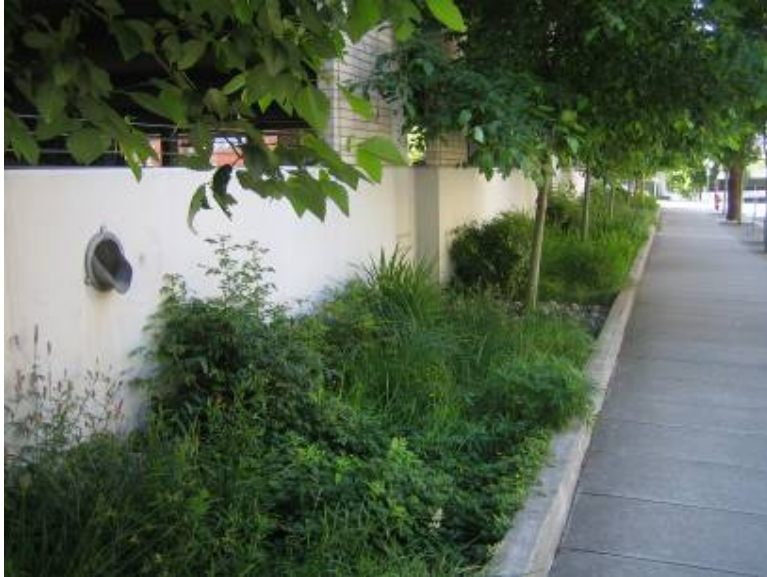
Fig. 6- Canteiro pluvial ao lado da Garagem do Liberty Center em Portland, Oregon. Fonte: Nathaniel S. Cormier
