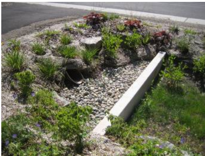
Fig. 21-Vista de uma bacia de sedimentação na Grade Verde de Pinehurst, Seattle, Washington. Fonte: Nathaniel S. Cormier
