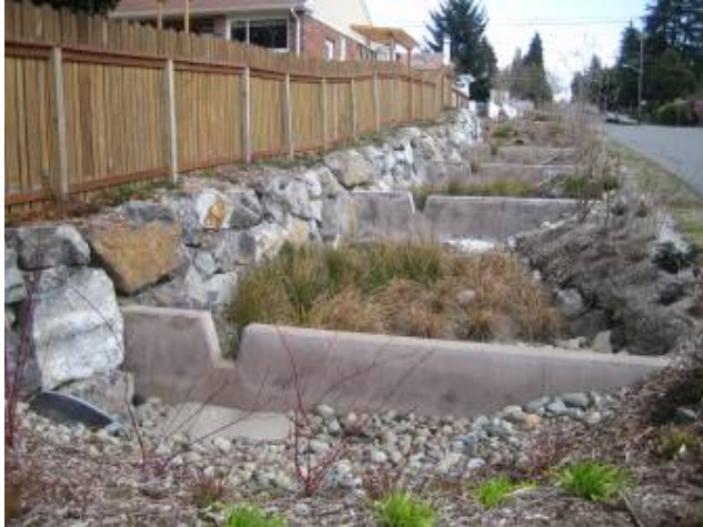
Fig. 20-Biovaletas logo após sua implantação em Broadview , hoje estas estruturas se encontram praticamente escondidas pela vegetação. Fonte: Nathaniel S. Cormier
