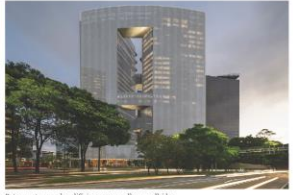
Fotomontagem do edifício com a malha escolhida A malha metálica escolhida é da marca GCD e constituída pelo do material AISI Tipo 316 SS. Sua máxima abertura é de 60% da área (vão de luz) e seu shgc é de 34%.
