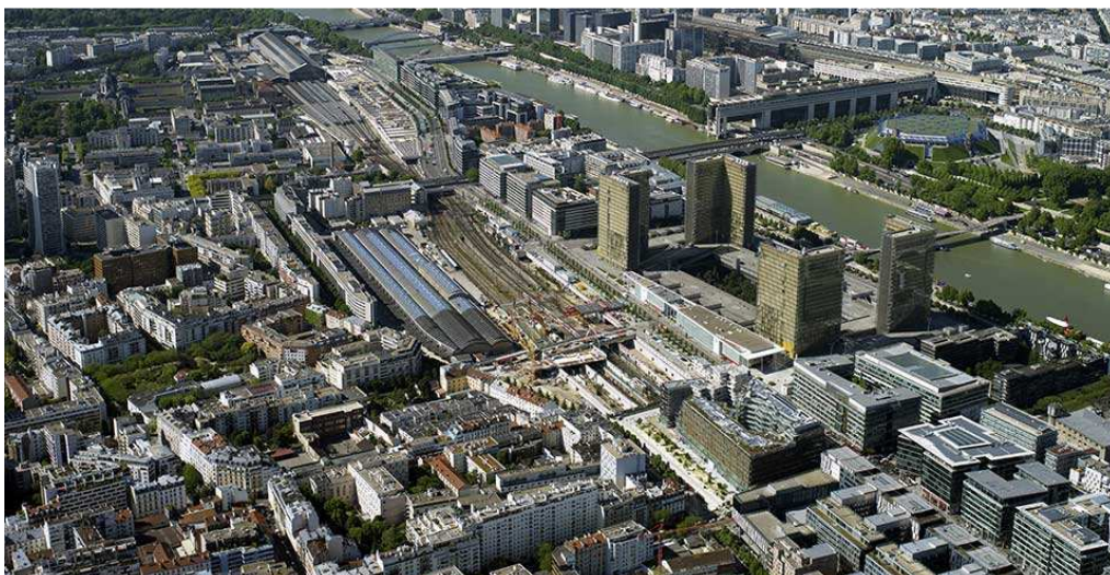
ZAC Paris Rive Gauche, após enterramento da via férrea.
