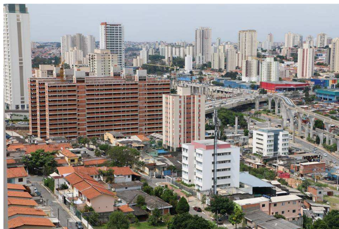
Edifícios Iguazu e Gutenberg, ao fundo Estevão Baião, em fase final de construção.
