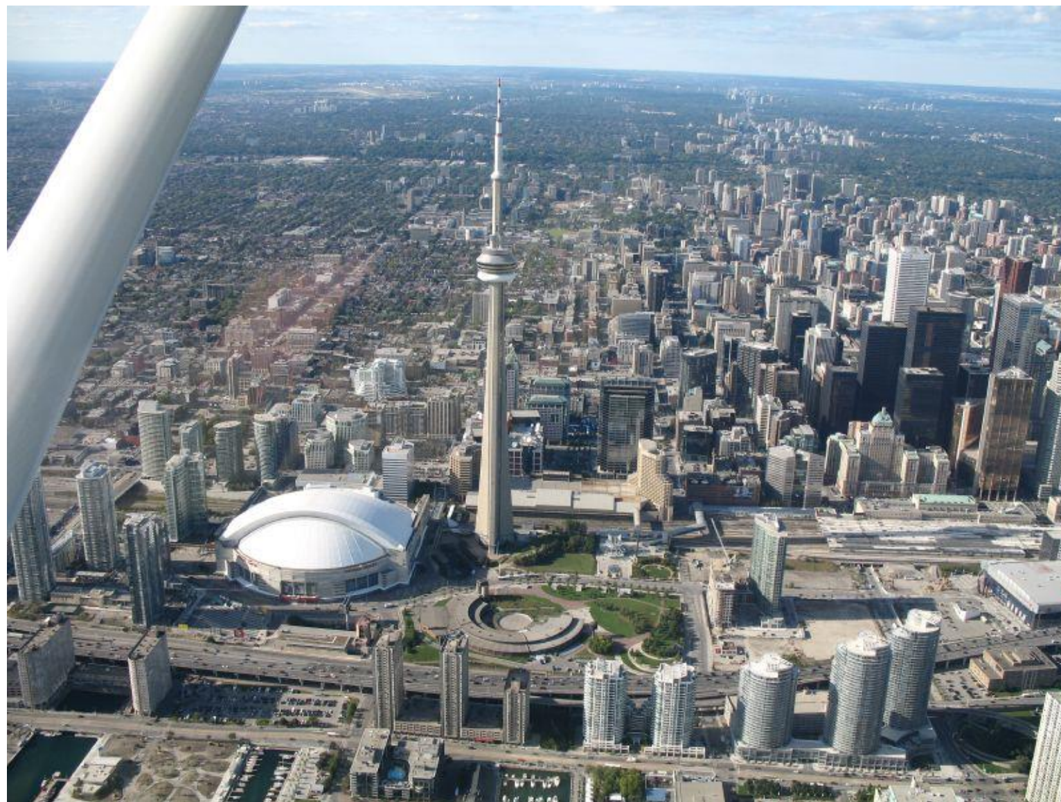
CN Tower, em Toronto, no Canadá, inaugurada em 1976; possui 553 m de altura
