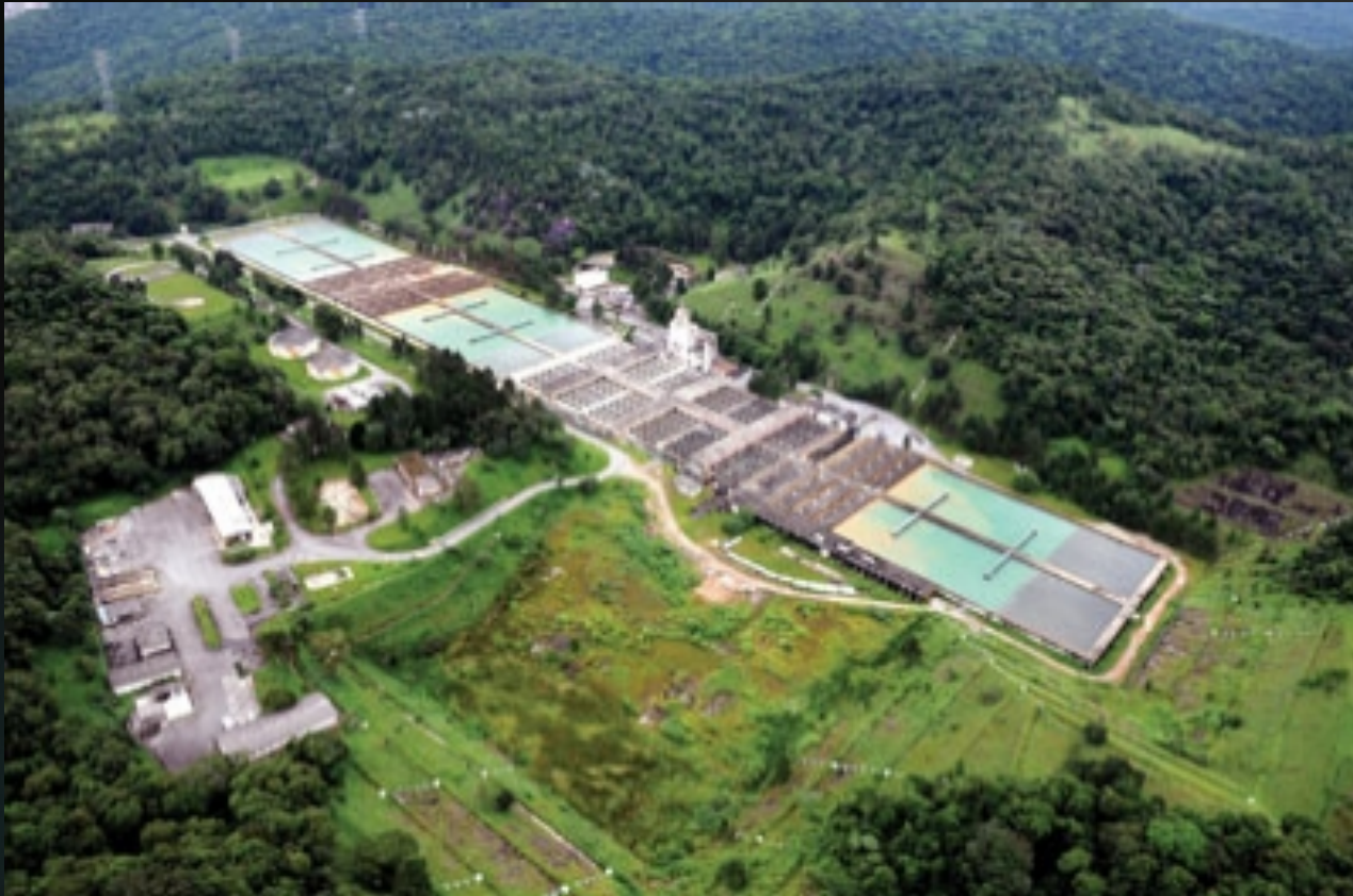
ETA de Guaraú em São Paulo A maior ETA da América Latina (33 m 3 /s)
