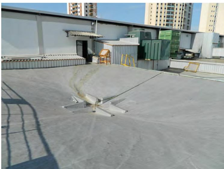
Figura 50 - Cobertura para captação de água da chuva.
