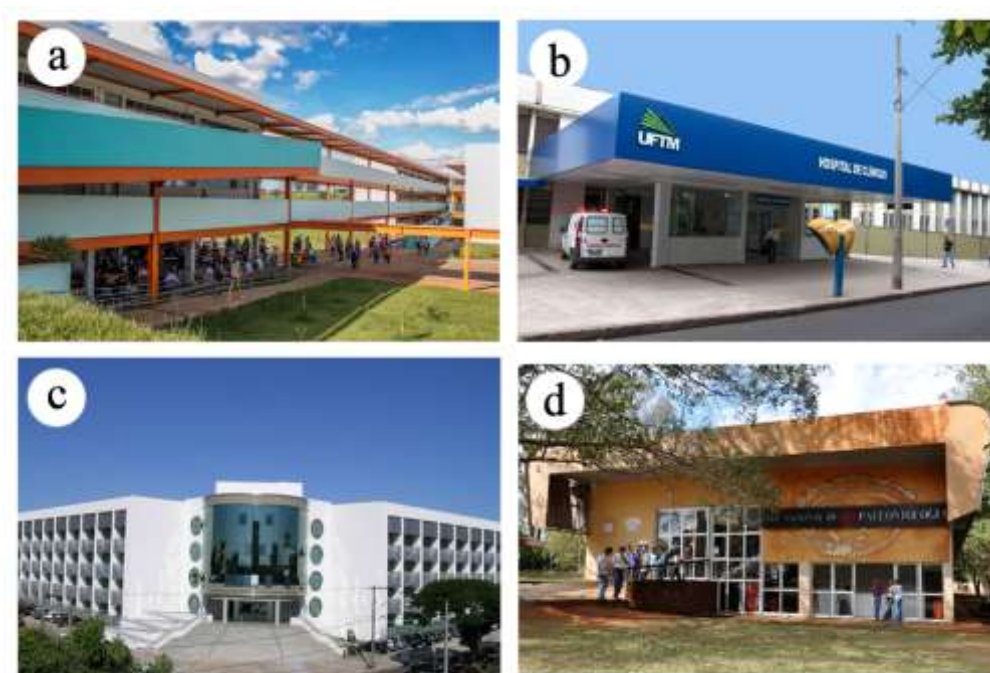
Figura 2. a) Unidade Univerdecidade – Campus Uberaba b) Hospital das Clínicas c) Centro Educacional – Campus Uberaba d) Complexo Cultural Científico de Peirópolis
