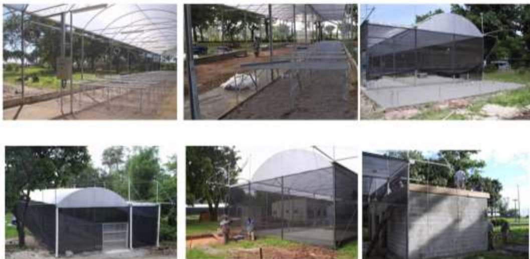
Figura 7 – Etapa de Construção: Viveiros e estufas.
