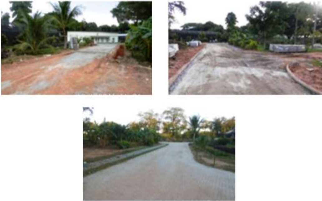
Figura 9 - Etapas de construção da Pavimentação Drenante
