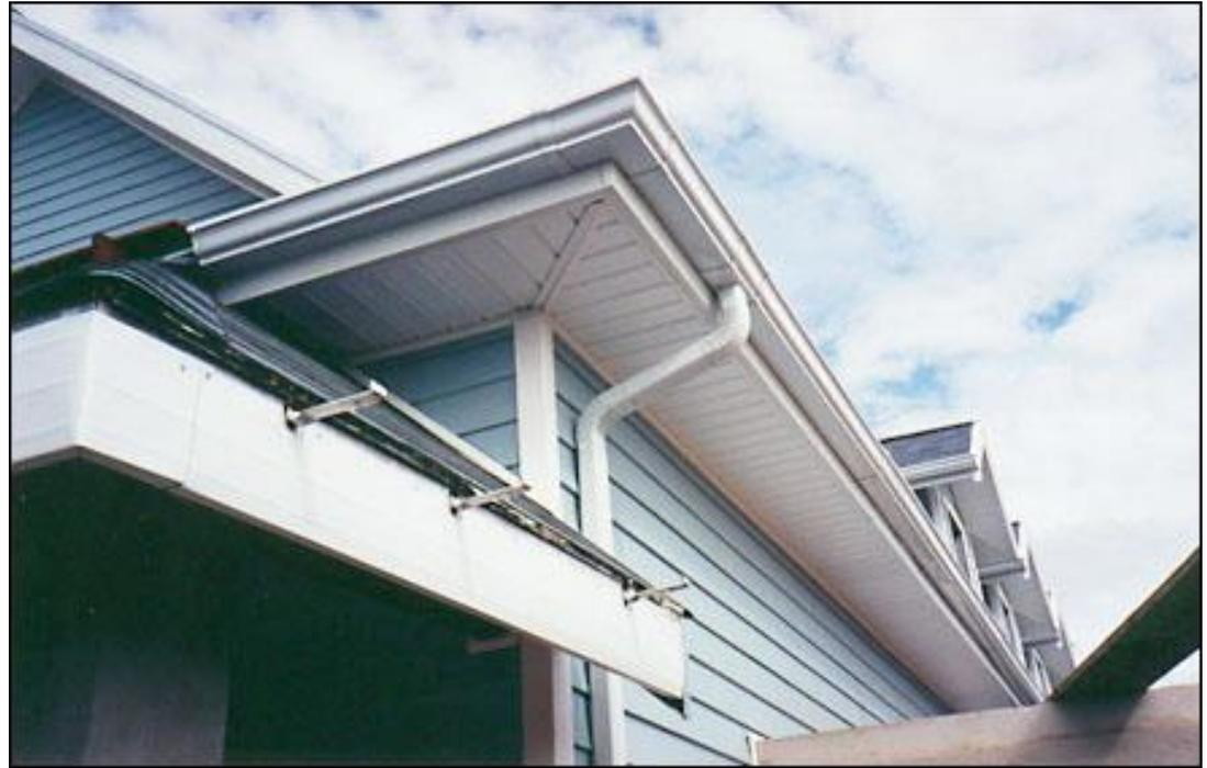
**Captação de água pluvial**
