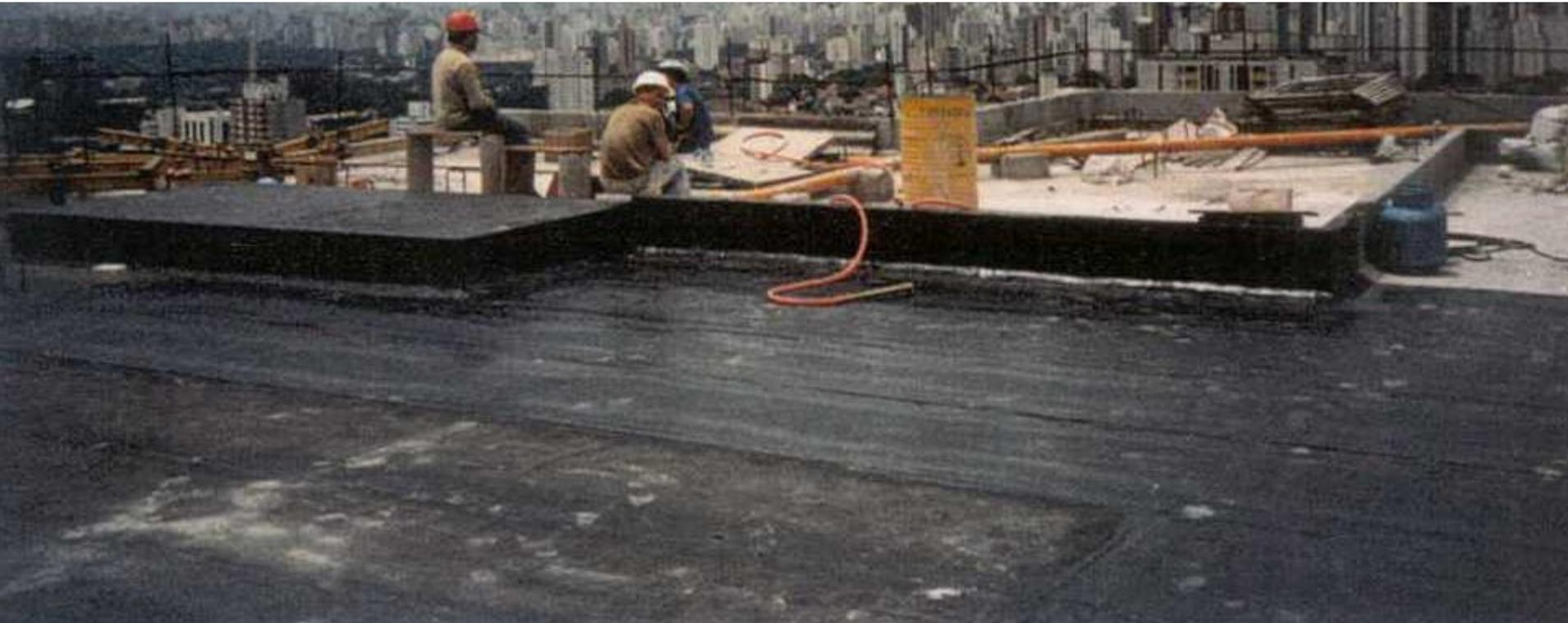
**Laje plana de concreto impermeabilizada:
