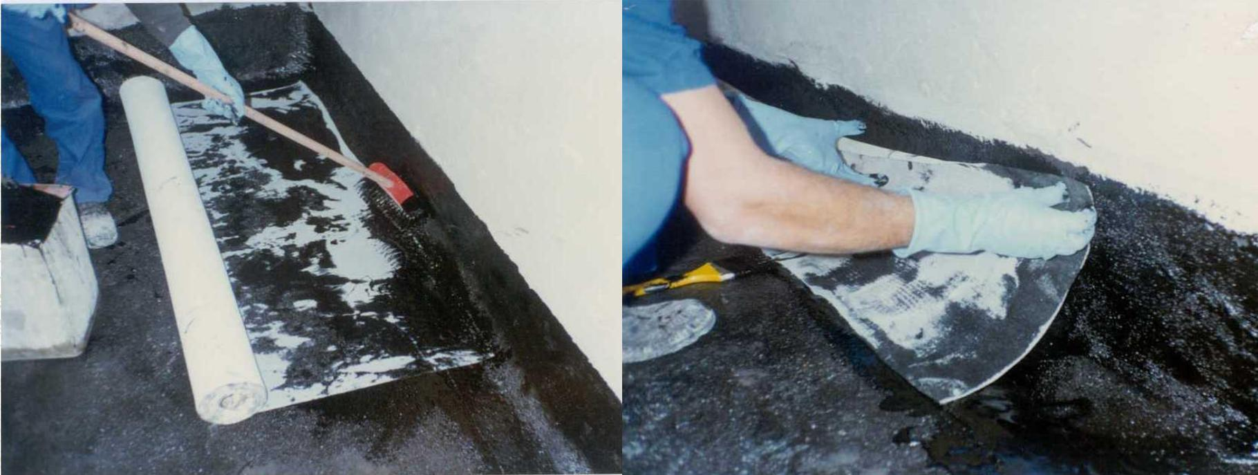
**Aplicação de membrana asfáltica: Frio**
