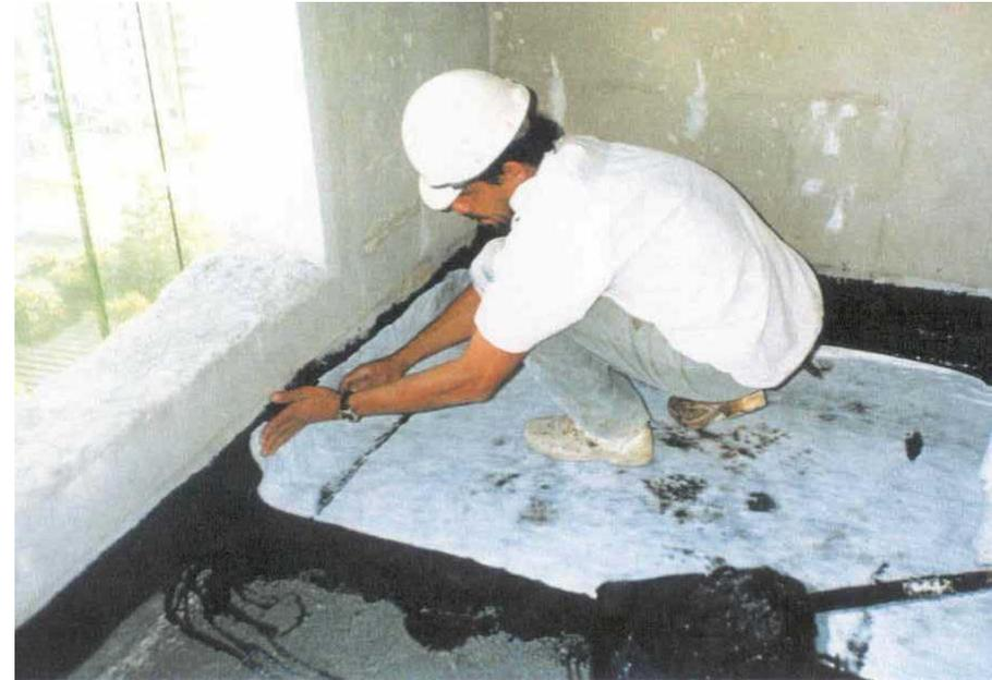
**Aplicação de membrana asfáltica: Frio**
