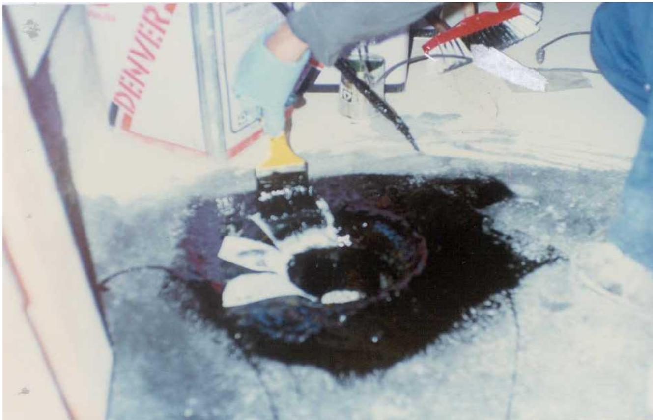
**Aplicação de membrana asfáltica: Frio**
