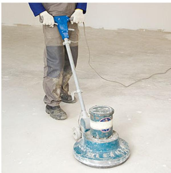
Após a limpeza da superfície, lixe o contrapiso com movimentos circulares em todas as áreas. Use uma lixadeira industrial com lixa grão 24.
