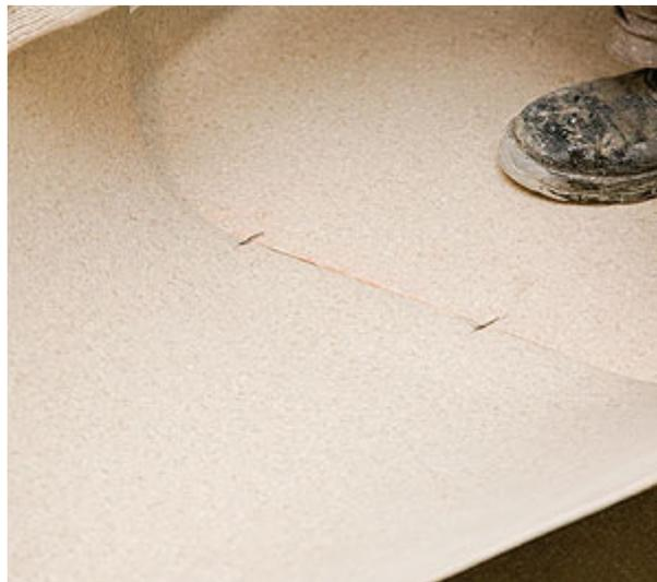
Espre de dez a 15 minutos para a secagem da cola acrílica e aplique a manta sobre a superfície segundo as marcações feitas previamente.
