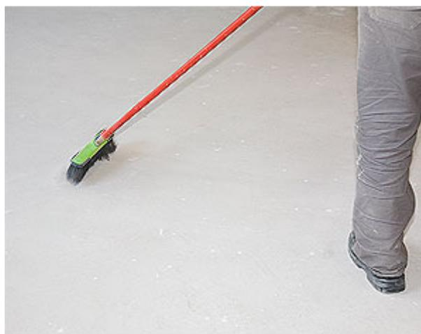
Certifique-se de que o contrapiso esteja regularizado. Retire o excesso de pó e de sujeira da superfície com o auxílio de uma vassoura de pelo.
