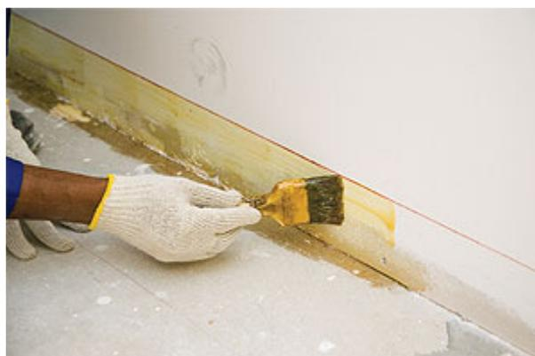
Passa a cola de contato no rodapé até o limite demarcado. Evite passar a cola fora do limite para não dificultar a limpeza posterior.
