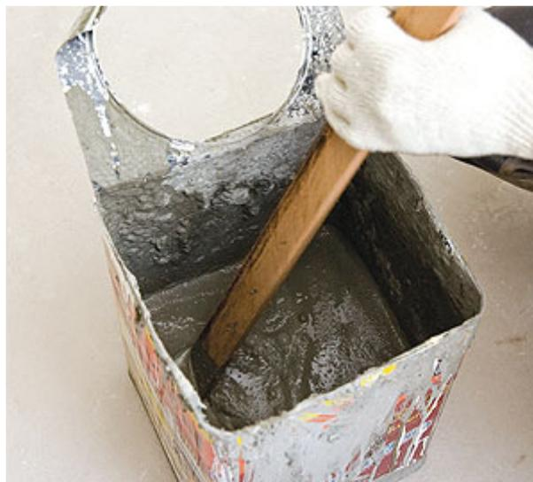
Prepare a massa para cobrir a porosidade do contrapiso. Para a primeira demão, use 3 l de água para cada litro de cola à base de PVA. Acrescente cimento conforme a necessidade e, de acordo com a situação do contrapiso, substitua uma parte do cimento por argamassa. Misture até formar uma massa homogênea. Use a mesma medida para a segunda demão, mas sem o acréscimo de cimento.
