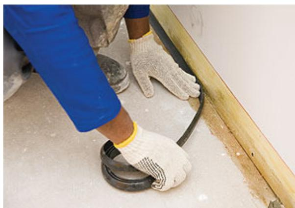
Após passar cola nas duas peças, inicie a colagem do suporte curvo na parte inferior do rodapé.
