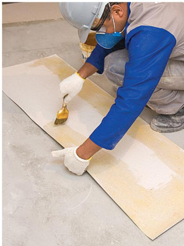
Em seguida passe uma faixa grossa de cola de contato nas laterais do fundo da manta.
