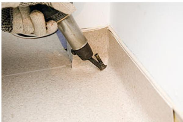
Depois de desbastar o cordão de solda nos cantos execute os ajustes com o soprador com a ponteira acoplada.
