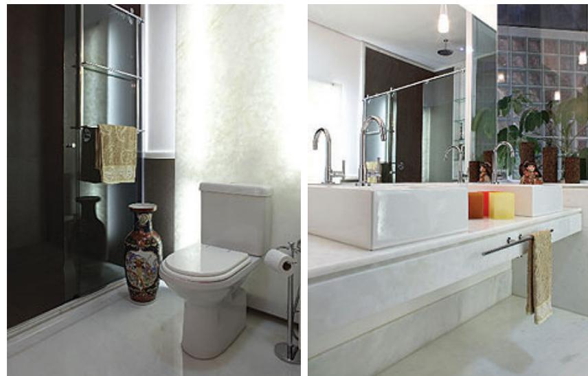
Para trazer sofisticação ao banheiro da suíte, o material escolhido para revestir bancada, parede e piso foi o mármore branco do Espírito Santo, polido e impermeabilizado com espessura de 2 cm, que associa a translucidez à ótima resistência. As placas foram assentadas com argamassa especial para mármore e rejunte acrílico. Na bancada, a colagem foi realizada com adesivo gel transparente. No detalhe da parede foi aplicada a iluminação, que propiciou efeito diferenciado na ambientação.
