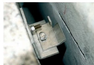
Foto 3 – Colocação do inserte com chumbador de expansão
