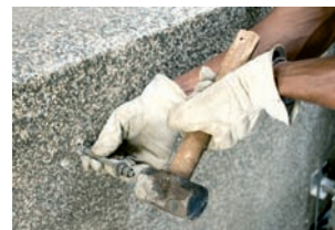
Foto 1 – Furo no concreto e limpeza do furo
