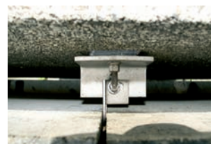
Foto 4 – Colocação da placa de rocha
