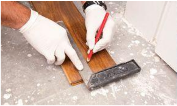
Marcação e recorte do revestimento de madeira
