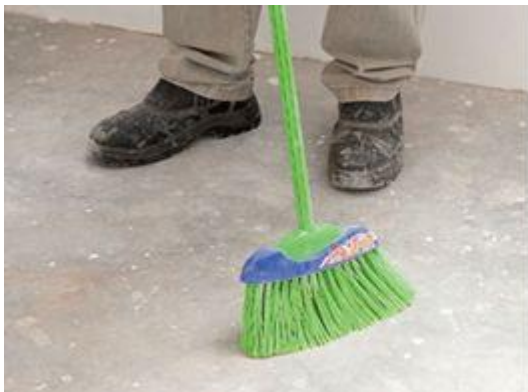
Limpeza do piso
