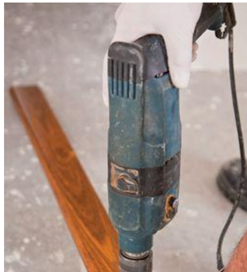
Execução de furos no rodapé
