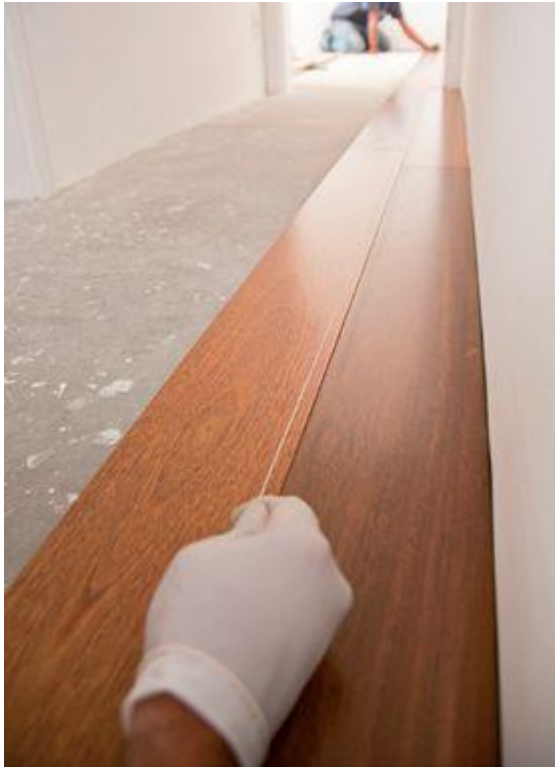
Verificação do alinhamento
