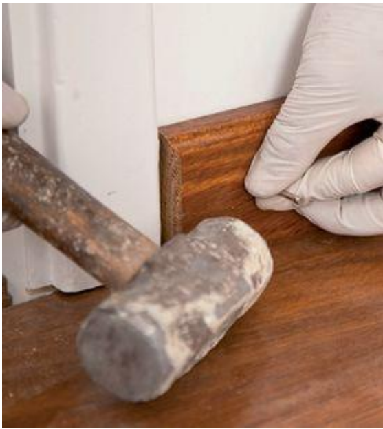
Fixação do rodapé com prego
