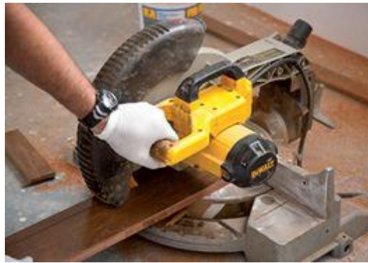
Corte com serra circular no tamanho do vão restante
