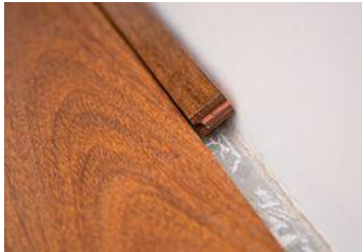
Colocação da última fileira de revestimento no vão
