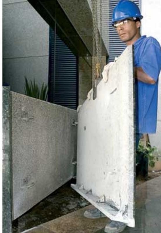
O custo mais elevado do sistema de fixação mecânica em comparação com sistemas aderidos não é decorrente da mão-de-obra, mas do processo como um todo. Ferramentas de içamento auxiliam os operários na colocação das placas nos insertes
