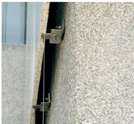
Imprescindível para a fixação dos insertes, a presença de uma parede atrás das placas não repercute automaticamente numa fachada ventilada, que exige dimensionamento para a passagem e renovação do ar
